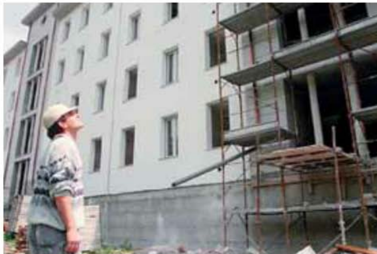
Un cantiere edile
